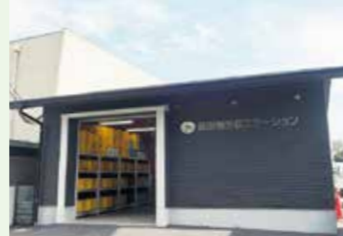
▲資源物回収ステーション外観
