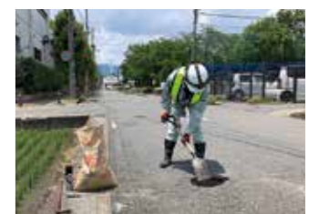
パトロールで発見した舗装面の補修
