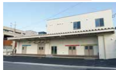
学校給食センター外観
