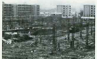
向日台団地第 2 期工事着手 (昭和 42(1967)年頃撮影)
