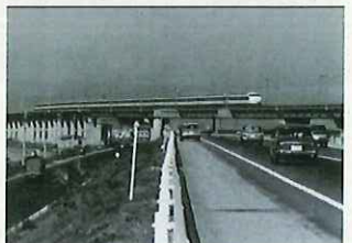
国道・新幹線・名神の立体交差 (昭和 42(1967)年頃撮影)
