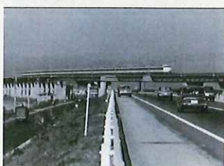
国道・新幹線・名神の立体交差 (昭和 42(1967)年頃撮影)
