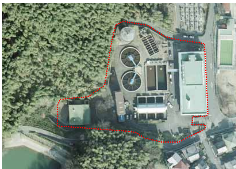
物集女西浄水場の緑化状況
