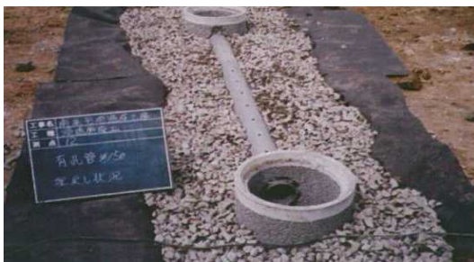
雨水流出抑制施設設置例
