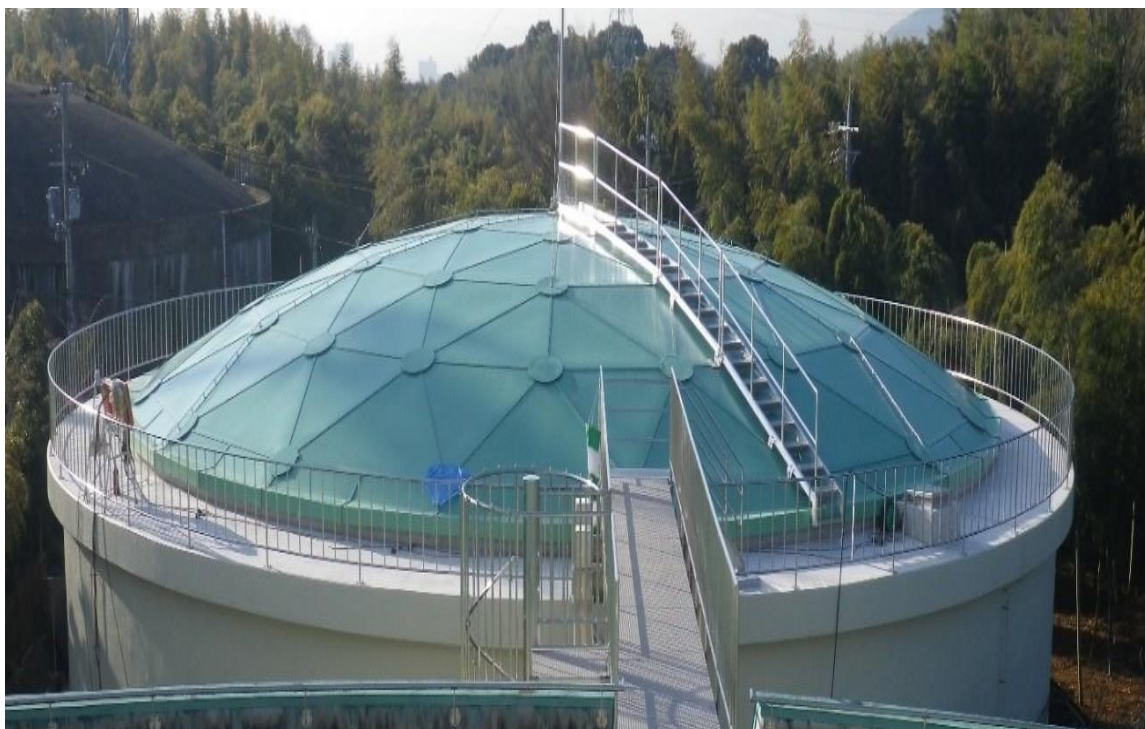
物集女第3配水池
