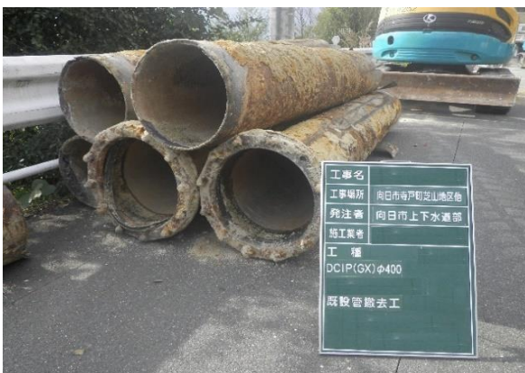
布設替に伴い撤去された既設管
