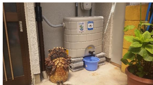
(雨水貯留タンク設置例)
