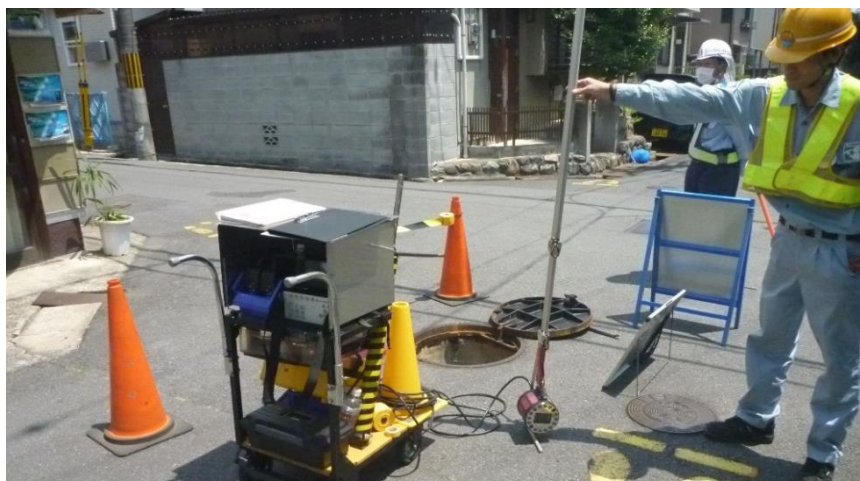
(写真1) 管口テレビカメラ調査
