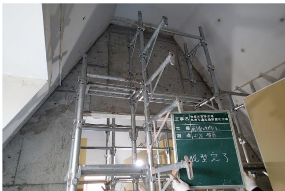
ろ過池（平成29年度竣工）
