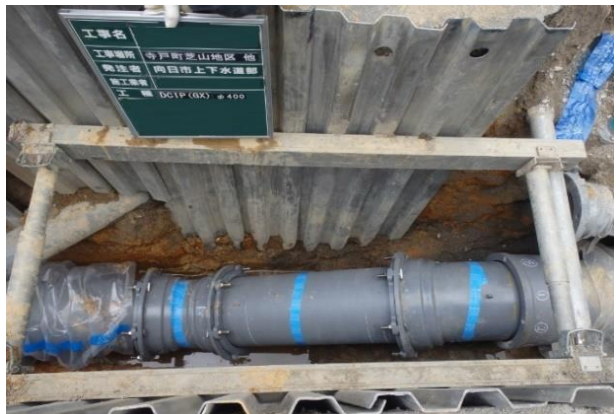
新たに布設した基幹管路
