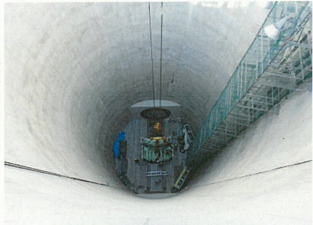
発進立坑内の状況
