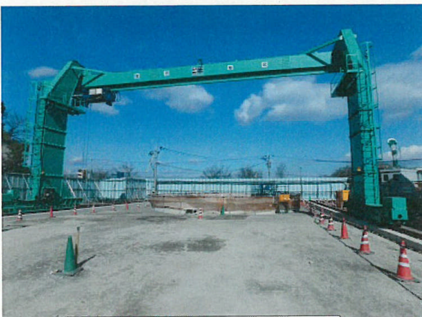
現場状況（門型クレーン）
