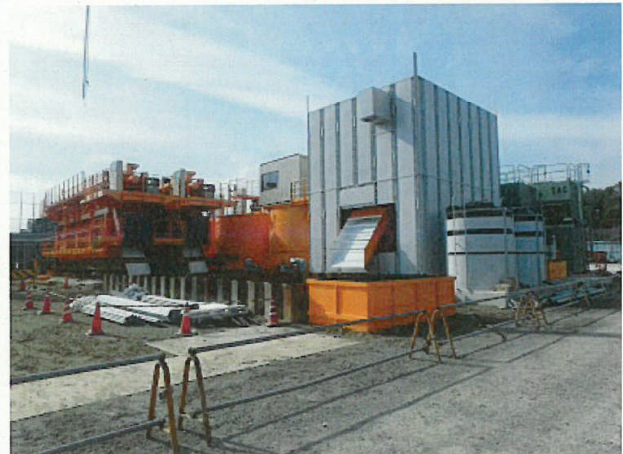
現場状況（土砂処理プラント）
