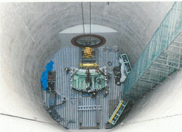
発進立坑内の状況（拡大）
