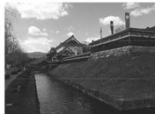
現在の勝龍寺城公園 (南辺を東から見る)
