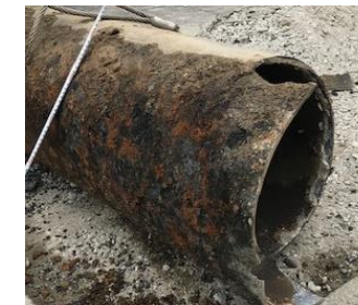
老朽化した水道管の撤去
