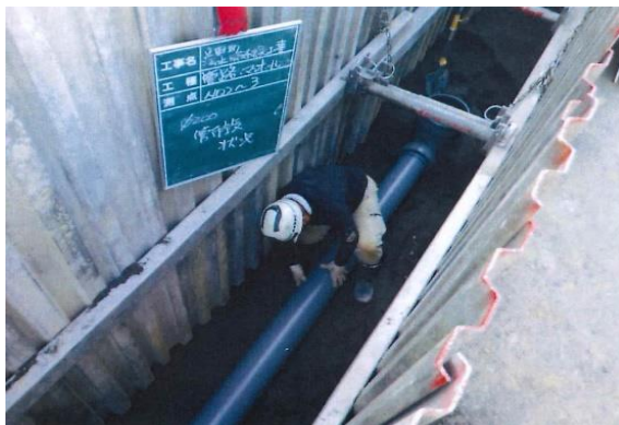
工事施工のイメージ
