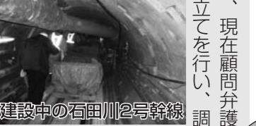
建設中の石田川2号幹線
