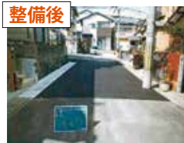
側溝、舗装改修事例
