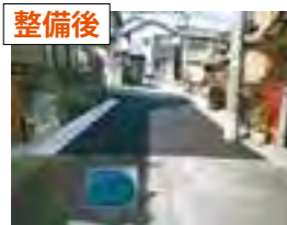
側溝及び舗装改修事例
