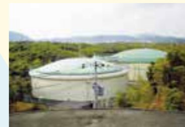
物集女配水池
