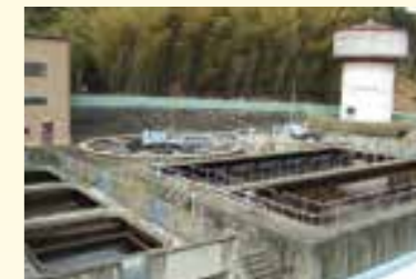
物集女西浄水場
