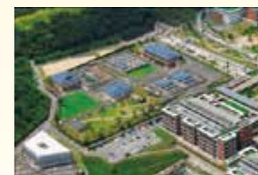
乙訓浄水場全景
