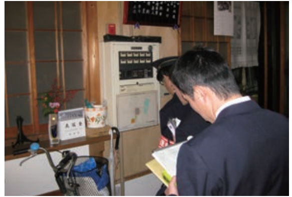
写真 5-5-4 消防立入検査
