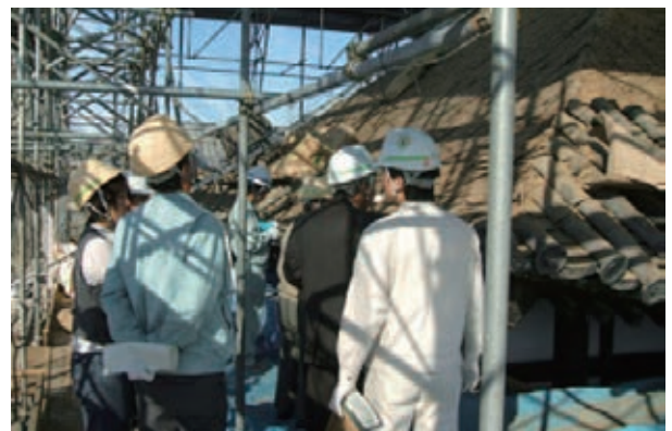
写真 5-2-2 文化財建造物修理現場の公開 (北真経寺)
