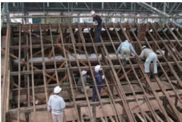
写真 5-2-1 文化財建造物の修理 (南真経寺)
