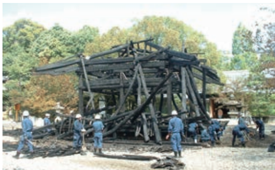
写真 5-5-1 文化財建造物の火災
