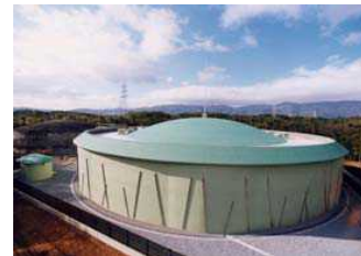
物集女配水池
