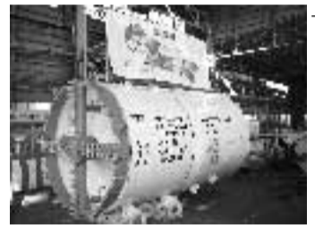
▶市役所西側の競輪場駐車場内に完成したシールドマシンを設置する発進立坑
