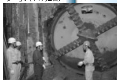
▲石田川1号雨水幹線のトンネルが掘削完了。(7月12日)
