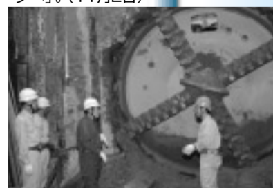
▲石田川1号雨水幹線のトンネルが掘削完了。(7月12日)
