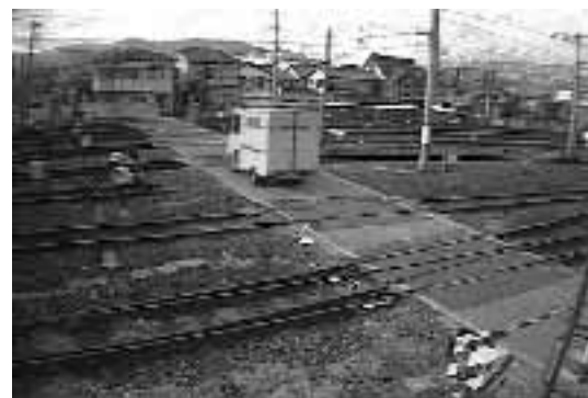
▲深田川踏切(森本町上森本・上町田)
