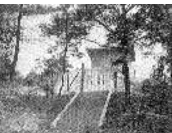
完成した配水池のようす 「広報向日町」32号(昭和35年8月)掲載
