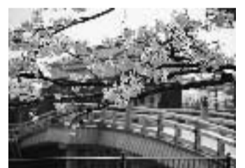
安居橋(八幡市)
