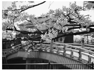
▲安居橋(八幡市)
