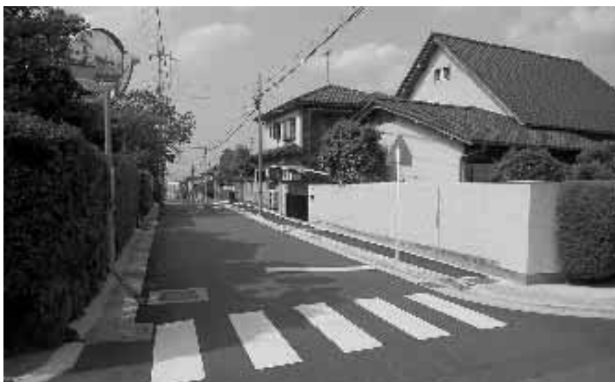
▲歩道の改良 寺戸鶏冠井幹線(鶏冠井町荒内)
