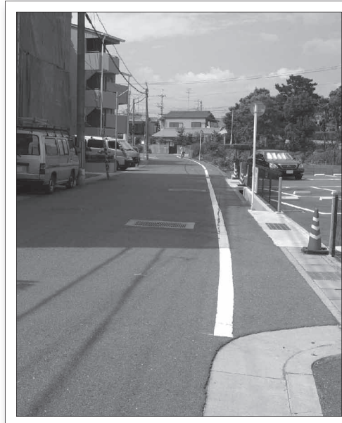
同じ地点から。アスファルト舗装された道路の右寄りの下を和井川が流れる(平成18年8月撮影)。
