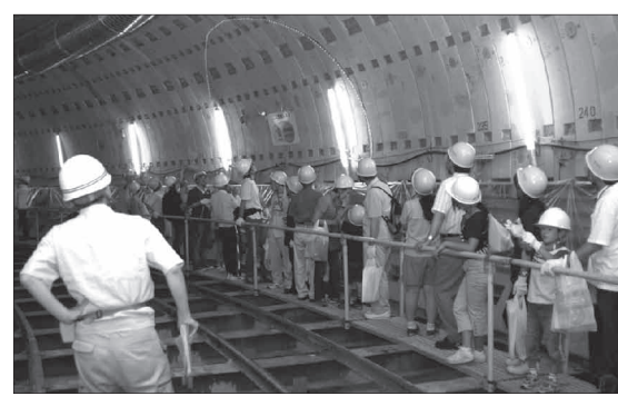
④【6月】浸水被害から私たちを守る「京都府いろは呑龍トンネル」の工事見学会を開催
