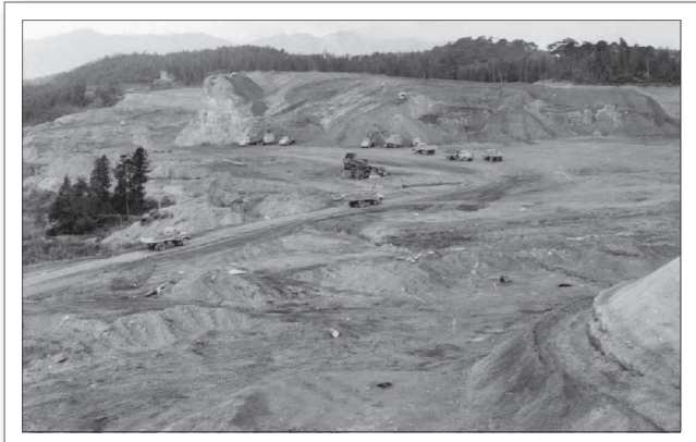
▲名神高速道路の盛土に使う土砂のため削られる向日丘陵。向日神社の裏側から寺戸町下村明夫さん撮影。
