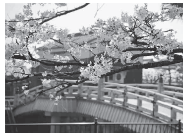
▲安居橋(八幡市)
