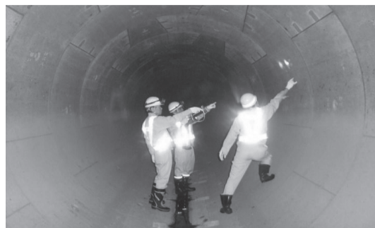
▲石田川1号幹線の点検
