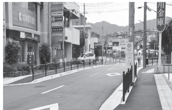
▲市道第2087号線拡幅改良
