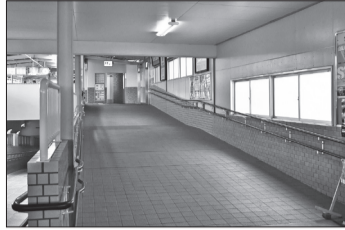
▲バリアフリー化で傾斜が緩くなった阪急西向日駅
