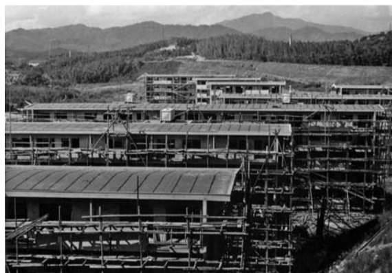
▲府営住宅向日台団地工事の様子
