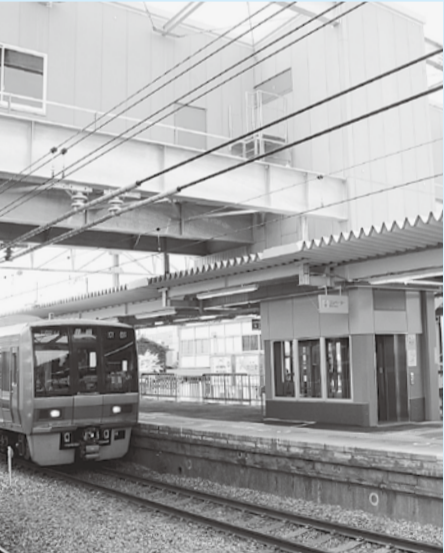
駅舎とホームをつなぐ線橋とエレベーター
