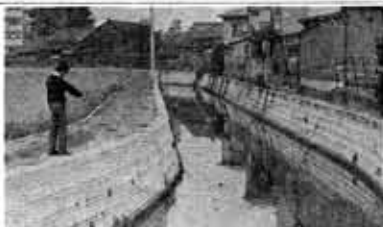
(寺戸川都市下水路の改修)
