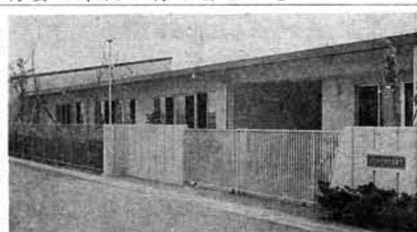
(第6保育所の建設)
