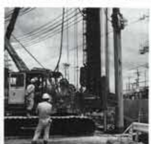
雨水調整管きょ工事現場
