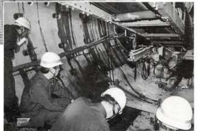
掘削現場の先端部分で作業をみるパトロール参加者
