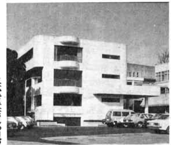
完成した市庁舎新館
