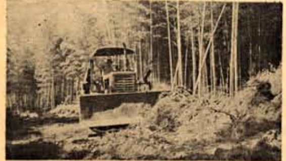
西ヶ丘農業開発道路 6月10日暫工以来市農4米延長約1000米が概ね出来上り(約35%)極めて順調に工事は進行しています。(6月末日現在) 写真はブルドーザーによる工事現場
