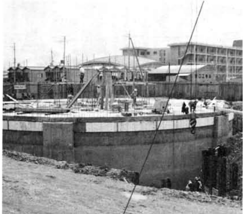
建設中の上植野浄水場
