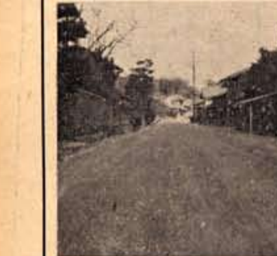
舗装できる 府道向日町線の一部
