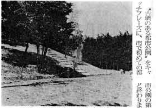
(第一期工事が終わった都市公園)
