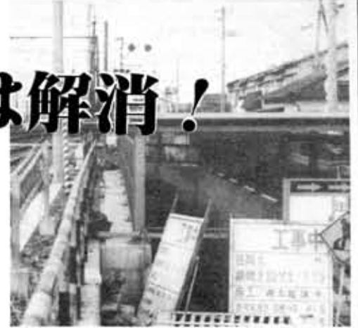
▲ 開通間近の森本地下道
