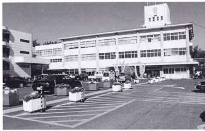
改良工事が行われる市役所庁舎前広場
