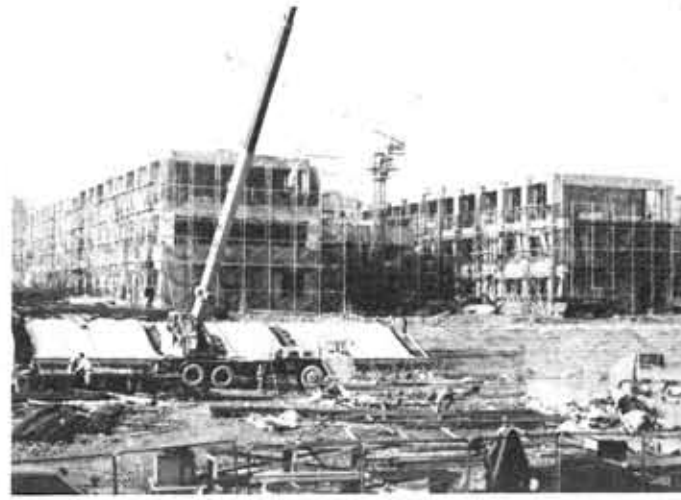
4月開校をめざし、順調に進む第6向陽小の建設工事
