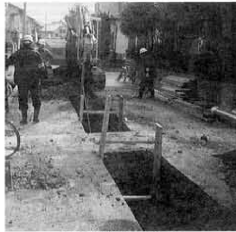
着々と進む下水道工事
