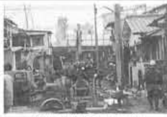
整備が進む公共下水道
