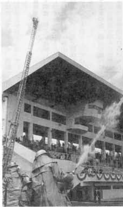
バンクに向かって一斉放水する消防署・団員 向日町競輪場
