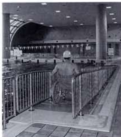
スロープや手すりにより、すべての人の利用に配慮している
