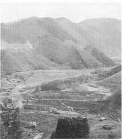
着々と工事が進む日吉ダム建設現場
